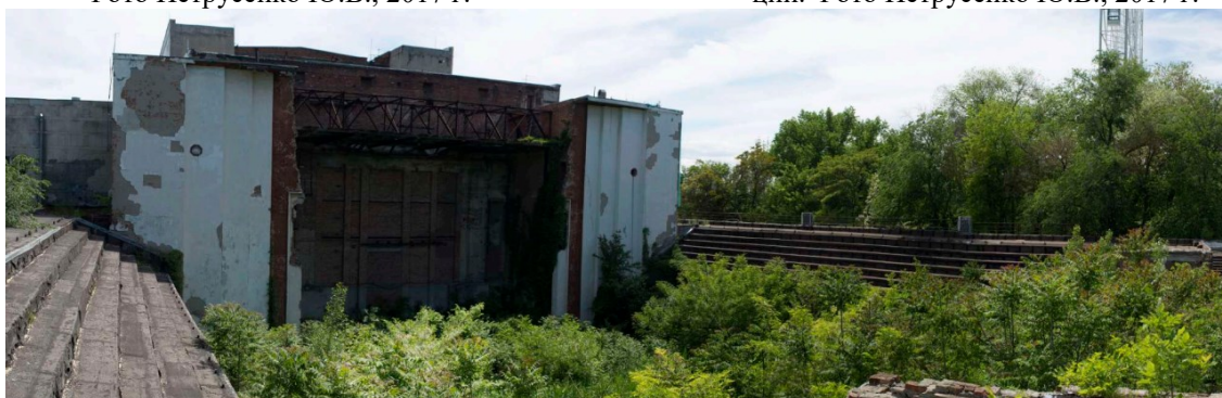
Рис. 9. Зеленый театр, вид на сцену с трибунами до реконструкции. Фото Петрусенко Ю.В., 2017 г.
